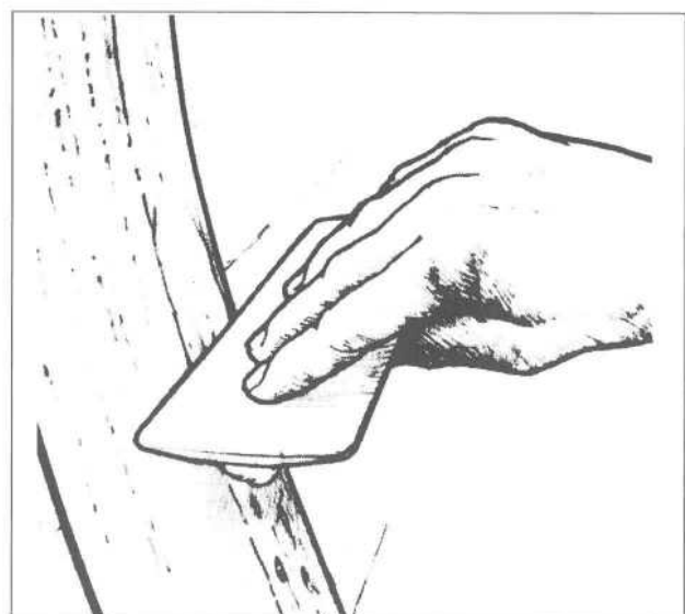
Abb. 4-5 Die noch offenen Löcher werden mit Spachtelmasse ausgefüllt.
